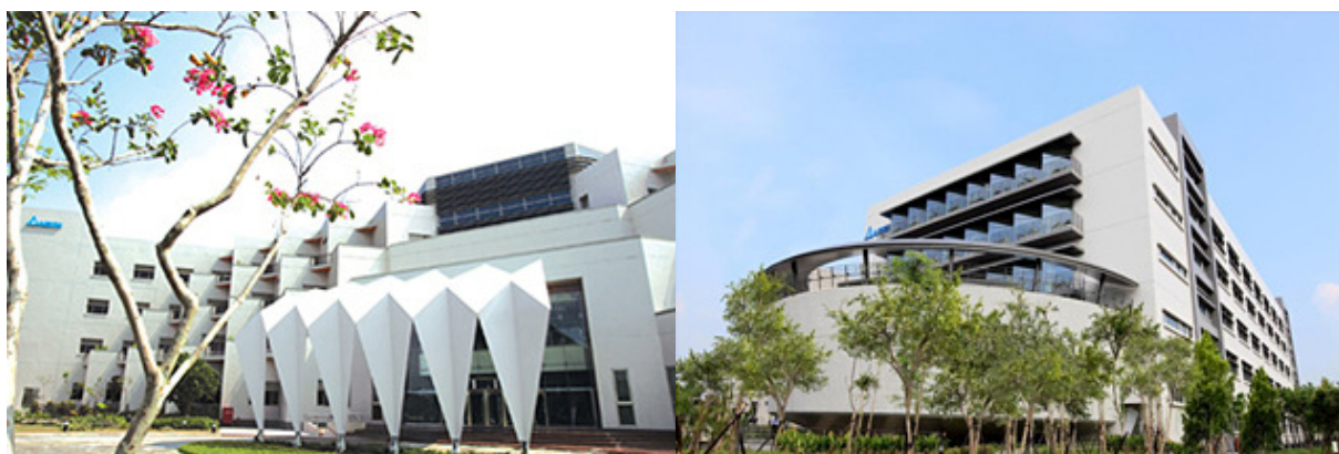
台達電在台南科學園區打造的 EEW 鑽石級、綠色工廠一期、二期。圖片來源：台達電子官方網站
